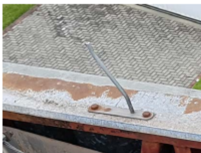
Captor e suporte do cabo do para raio fixado na estrutura sobre o rufo-capa
