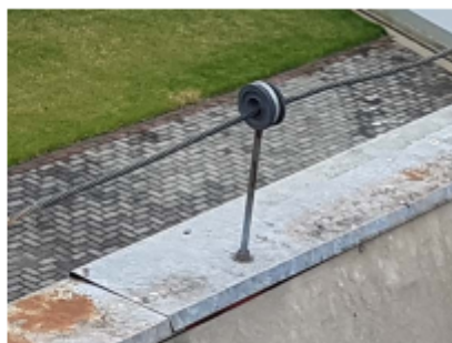
Captor e suporte do cabo do para raio fixado na estrutura sobre o rufo-capa
